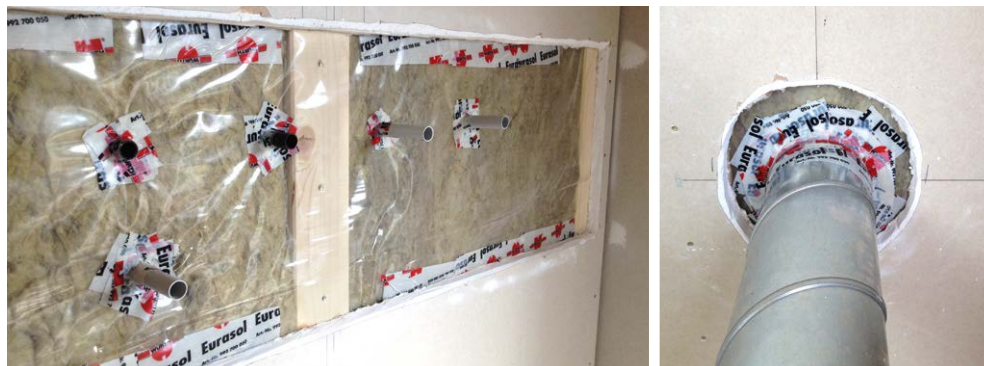
Монтаж закладных для измерительных датчиков в панельно-каркасных домах
