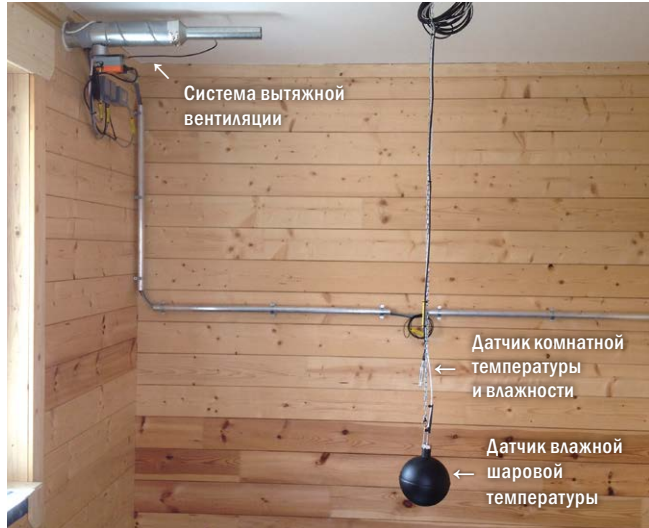
Датчики комнатной температуры и влажности и влажной шаровой температуры (на примере дома из блок-хауса)
