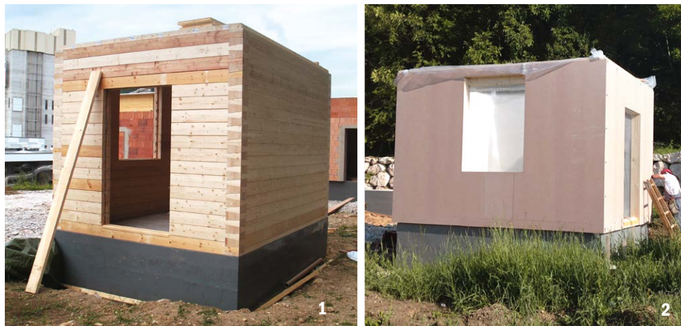
Опытные дома: 1 — деревянный дом из бруса, 2 — панельно-каркасный
